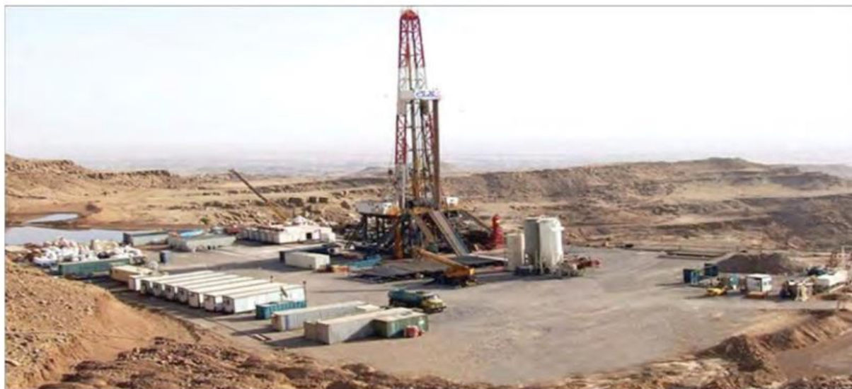
شکل (۲) محل حفاری چاه آب ژرف سیستان
