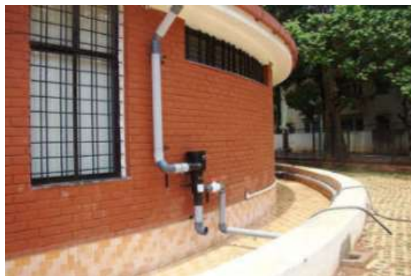
شکل ۵- لوله کشی و انتقال آب باران جمع آوری شده از پشت بام [۱۰]
